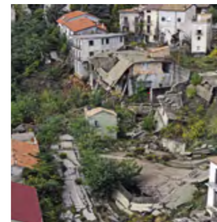
LANDSLIDE Cerzeto, Cosenza, 2005
