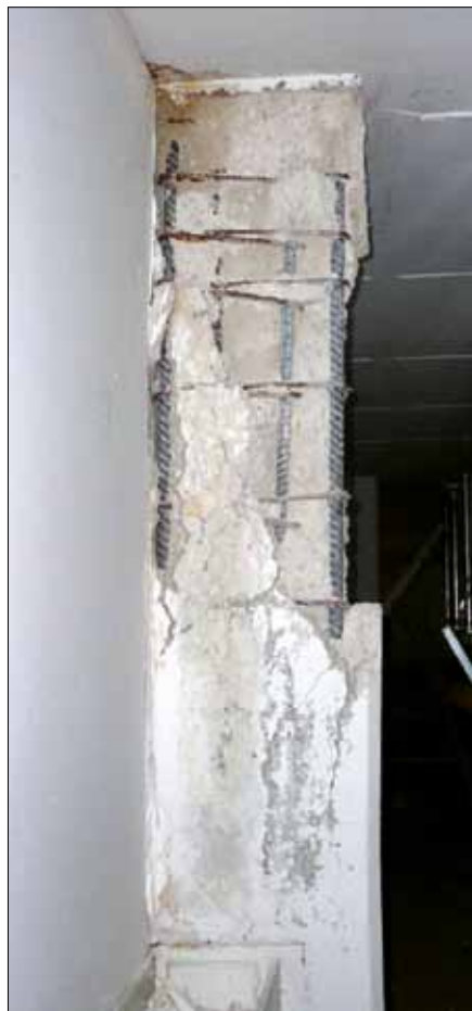
Figura 5.1 a), b) e c): Danneggiamento locale con espulsione del copriferro causato da insufficienti dettagli di armatura. Livello di danno nelle travi e nei pilastri: D3 (terremoto Abruzzo 2009).
