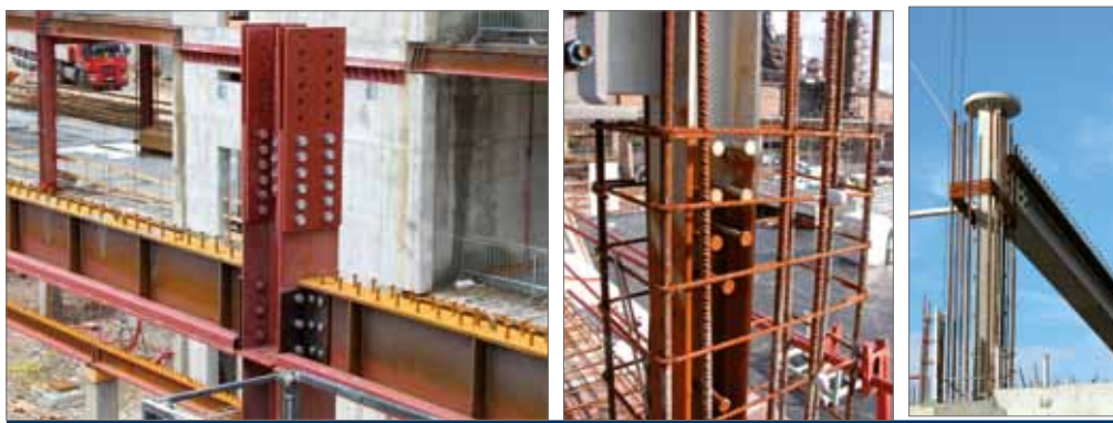
Figura 4.3. Esempi di strutture miste acciaio-calcestruzzo: colonne con connettori di un edificio multipiano per uffici in Lussemburgo.
