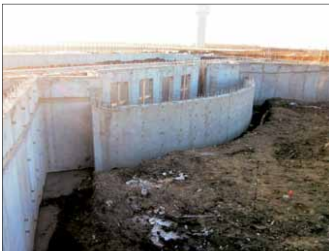
Figura 4.28. Pannelli gettati in opera.
