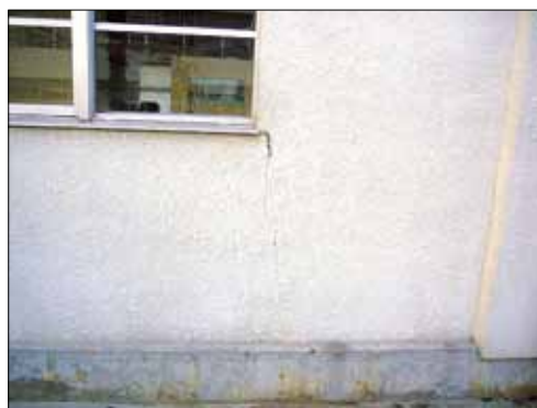
Figura 7.1: (a) Piccole fessure in concomitanza di una finestra e (b) marcata fessura orizzontale alla base dell’edificio (Foto: Y. Sakai) (Giappone 2011)
