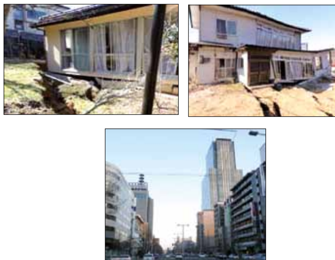
Figura 7.5: Danneggiamento di edifici per effetto dello scorrimento del terreno a Oritate 5-chōme (in alto a sinistra e a destra) ed edifici illesi nel centro di Sendai (in basso) (Giappone 2011)
