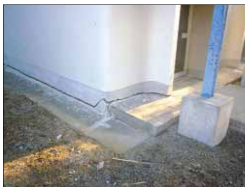
Figura 7.1: (a) Piccole fessure in concomitanza di una finestra e (b) marcata fessura orizzontale alla base dell’edificio (Foto: Y. Sakai) (Giappone 2011)
