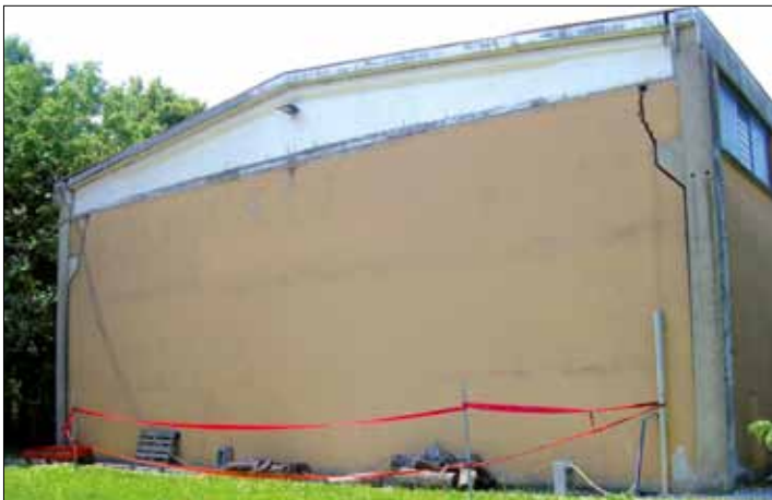
Figura 5.9: Fuori piombo dei pilastri di un edificio monopiano prefabbricato per possibile, ma non accertato, problema a livello della fondazione. Livello di danno: D4 (terremoto Emilia-Romagna 2012)
