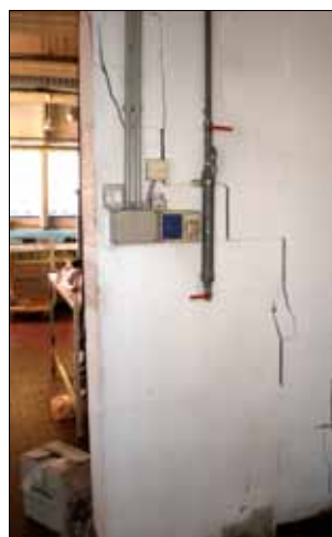
Figura 6.10: Esempi di fessurazione di pannelli di tamponatura interni (terremoto Emilia-Romagna 2012, Mirandola (MO))
