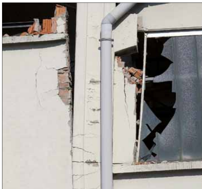
Figura 5.7 a) e b): Concentrazione di deformazione (rotazione) in un pilastro di un edificio con travi principali trasversali a causa della distribuzione irregolare dei tamponamenti (visione globale (a) e dettaglio (b)). Livello di danno nel pilastro: D4 (terremoto Emilia-Romagna 2012, Mirandola, MO)
