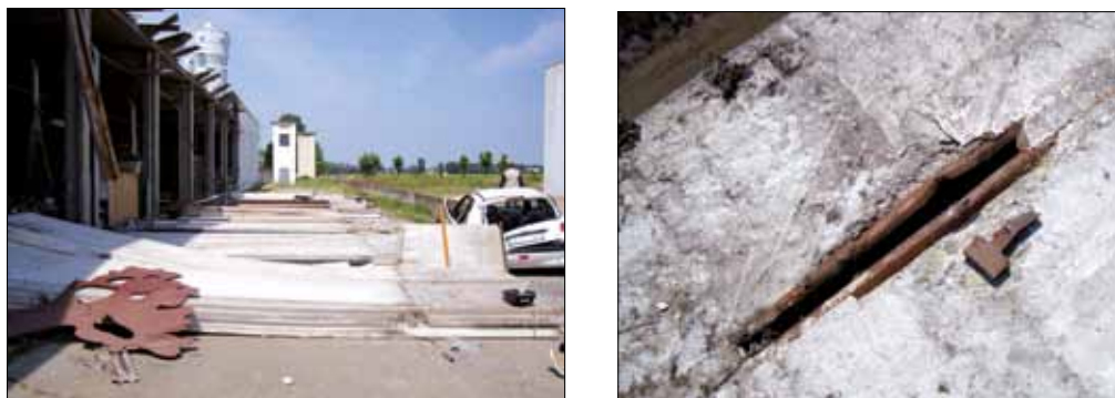
Figura 6.2: (a) Collasso di pannelli prefabbricati verticali in un edificio monopiano prefabbricato. (b) Profilo di ancoraggio slabbrato nel pannello e connettore caduto a causa della crisi della saldatura che lo collegava alla trave (terremoto Emilia-Romagna 2012, Medolla (MO))
