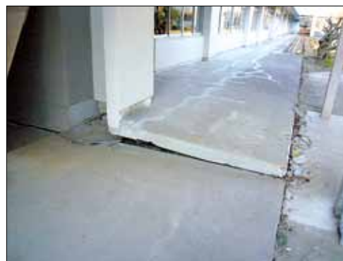
Figura 7.2: Fessurazione alla base dell’edificio (Foto: Y. Sakai) (Giappone 2011)
