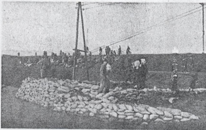
Fig. 9 - Messa in opera dei sacchetti a terra
