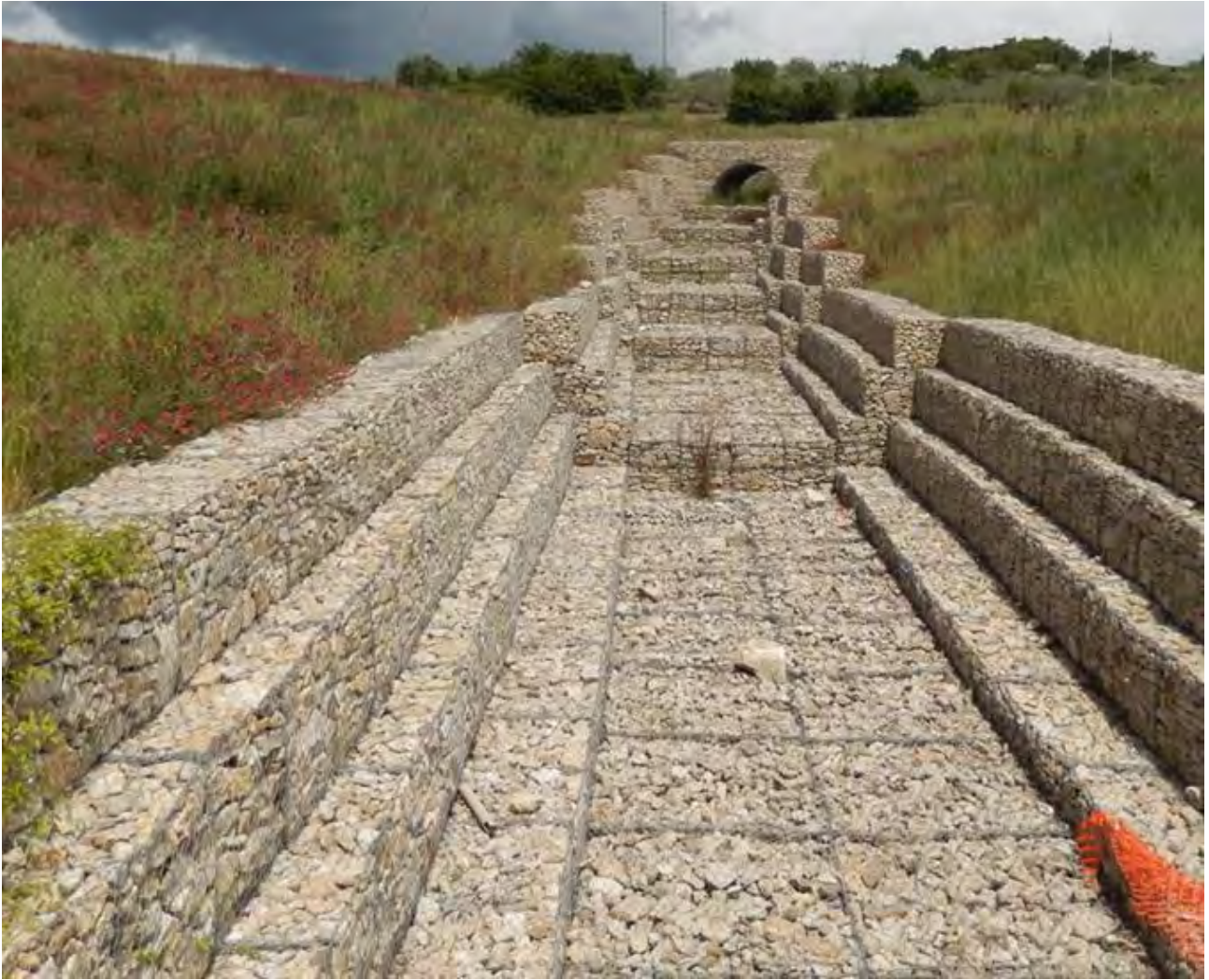
Figura 75 - Sistemazione alveo e sponde mediante utilizzo di gabbioni riempiti con materiale lapideo su un canale della frana di Montaguto.
