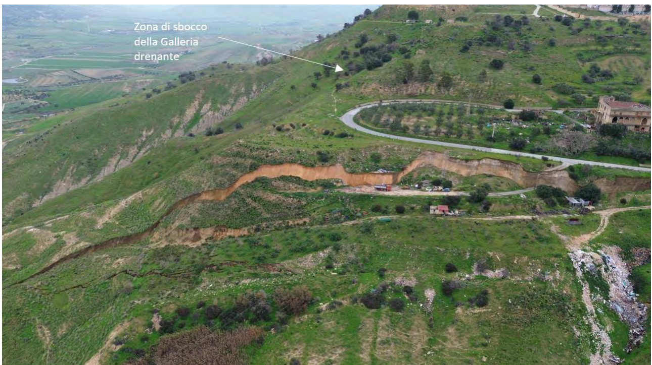
Figura 11 - Zona di sbocco della galleria drenante
