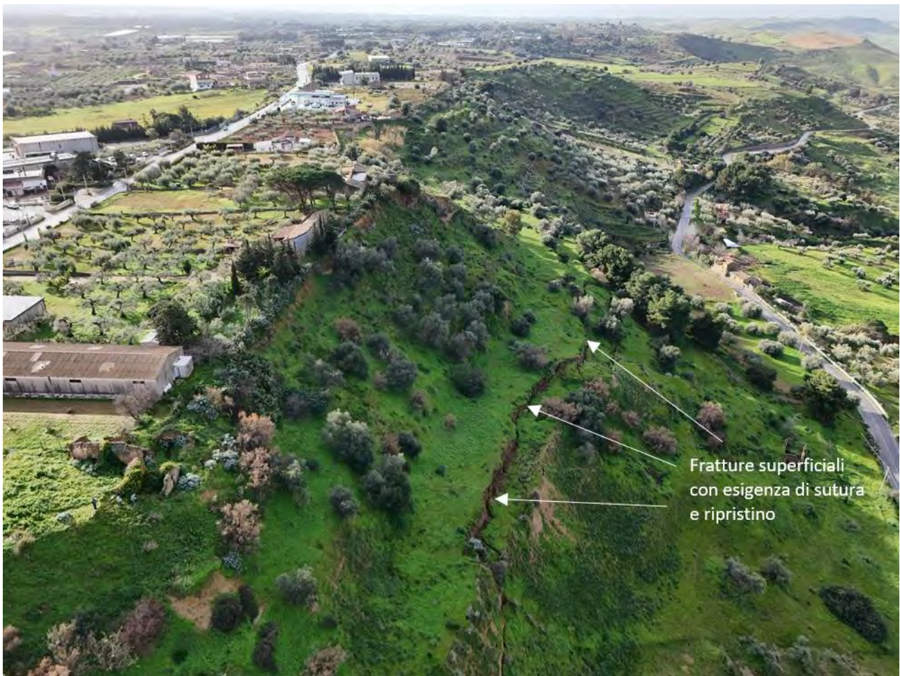
Figura 61 - Evidenza delle fratture superficiali con esigenza di sutura e ripristino.
