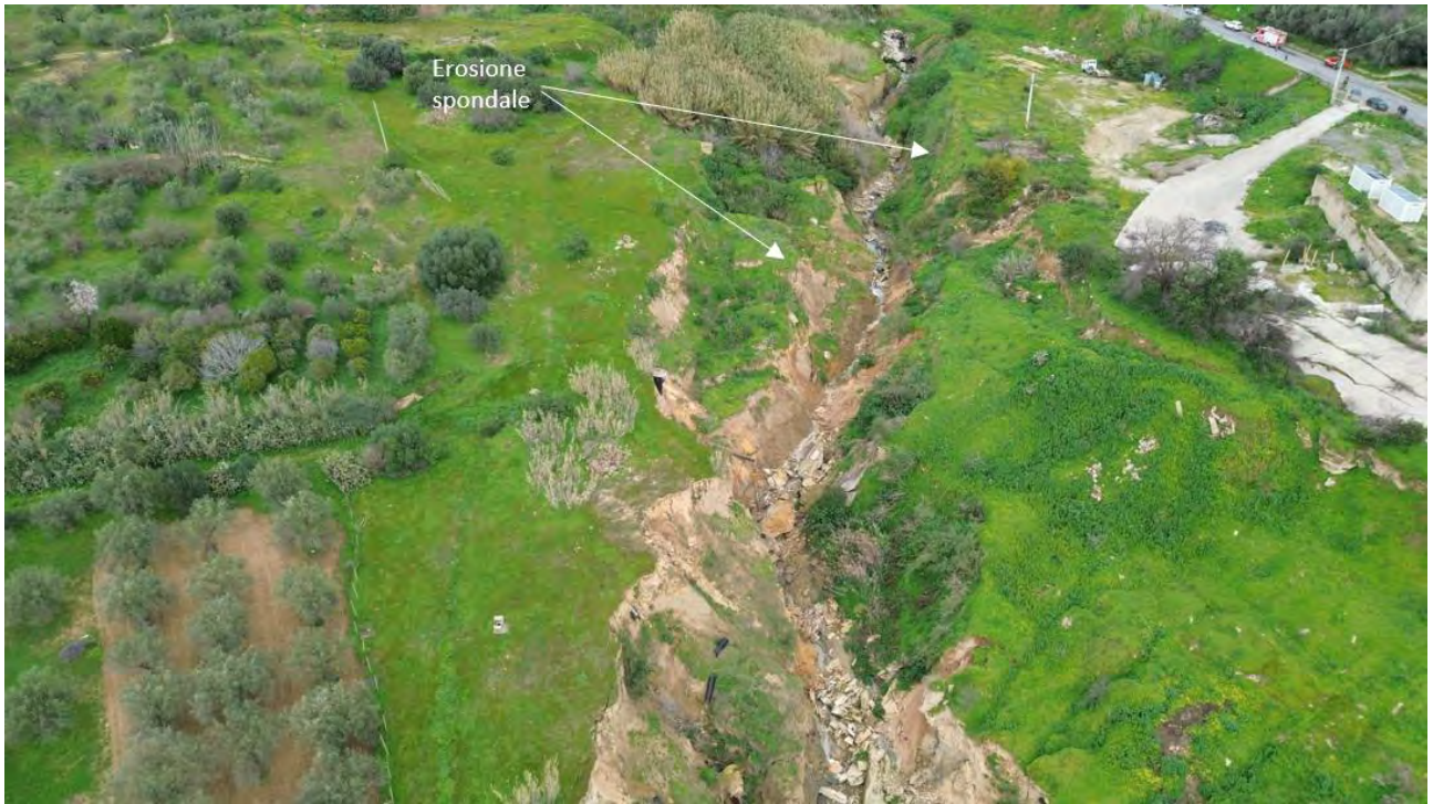
Figura 63 - Alveo e superfici spondali del torrente Benefizio in evidente stato di erosione e dissesto diffusi.
