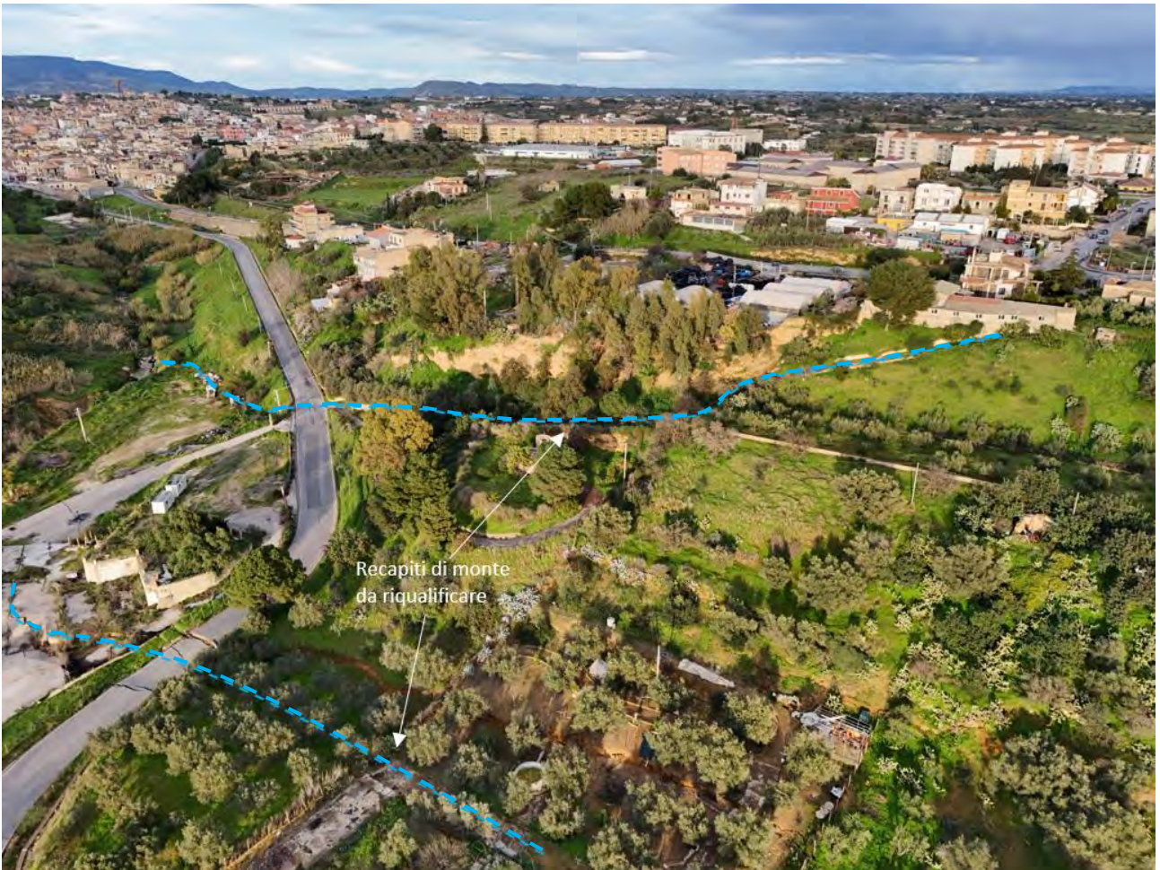
Figura 536 - Versante di monte della SP10 con necessità di sistemazione dei recapiti superficiali e di introduzione di sistemi di drenaggio profondi per la corretta regimazione delle acque di infiltrazione.
