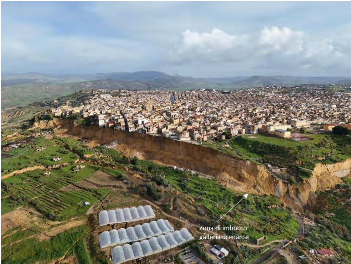
Figura 32 - Zona di imbocco della galleria drenante.
