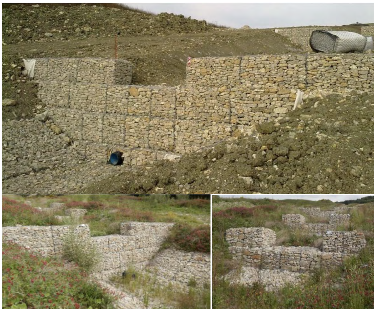
Figura 72- Esempi di realizzazione di briglie in gabbionate riempite con materiale lapideo nei pressi della frana di Montaguto.
