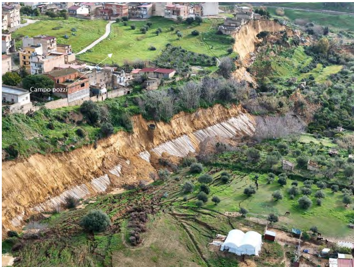
Figura 37 - Zona di realizzazione del campo pozzi.
