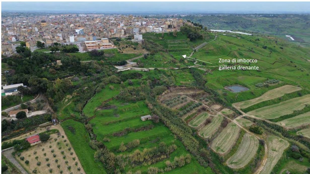
Figura 27 - Zona di imbocco della galleria drenante.
