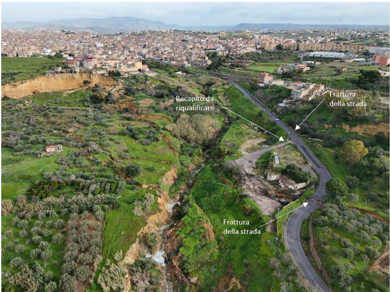
Figura 49 - Zona di interruzione della strada SP10 con necessità di ripristino stradale e di riqualificazione dei recapiti di monte, di attraversamento e di valle rispetto alla strada.
