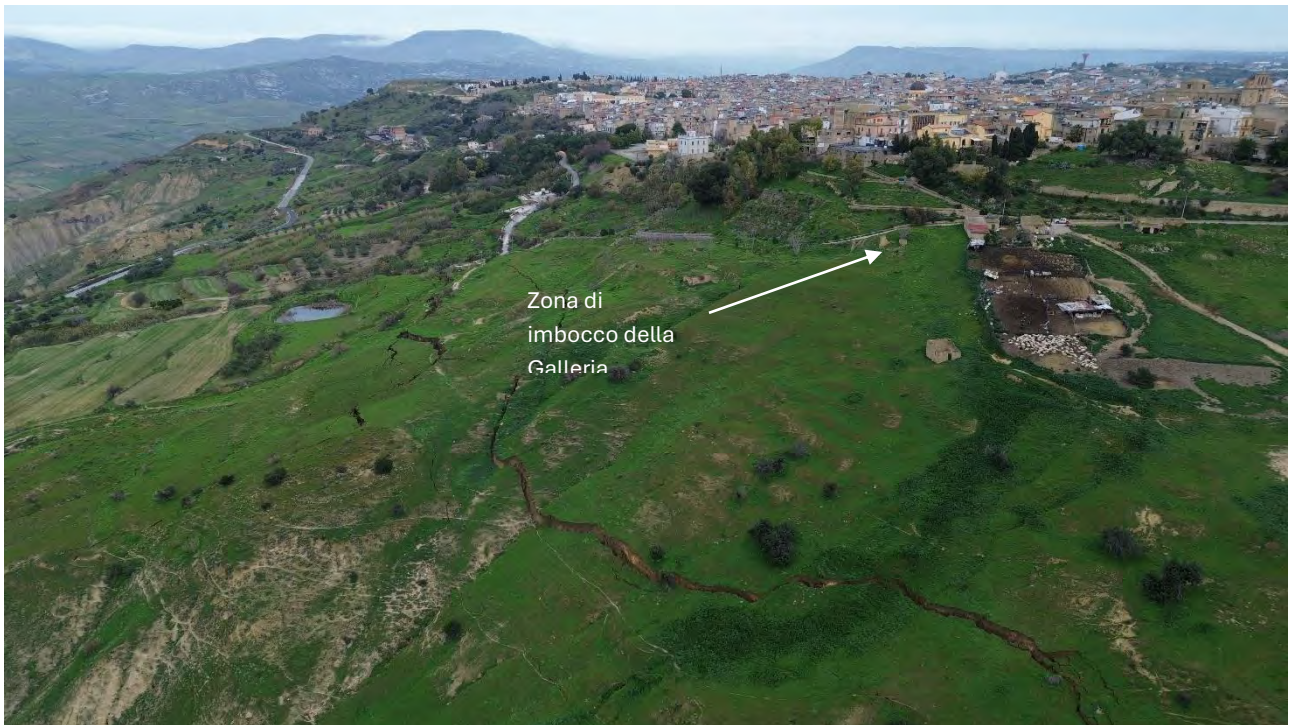
Figura 10 - Zona di imbocco della galleria drenante.
