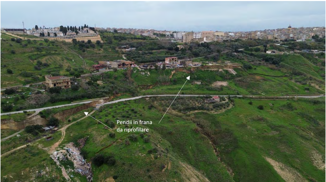
Figura 16 - Riprofilatura dei pendii nella zona compresa tra il tratto di monte e quello di valle della SP12.
