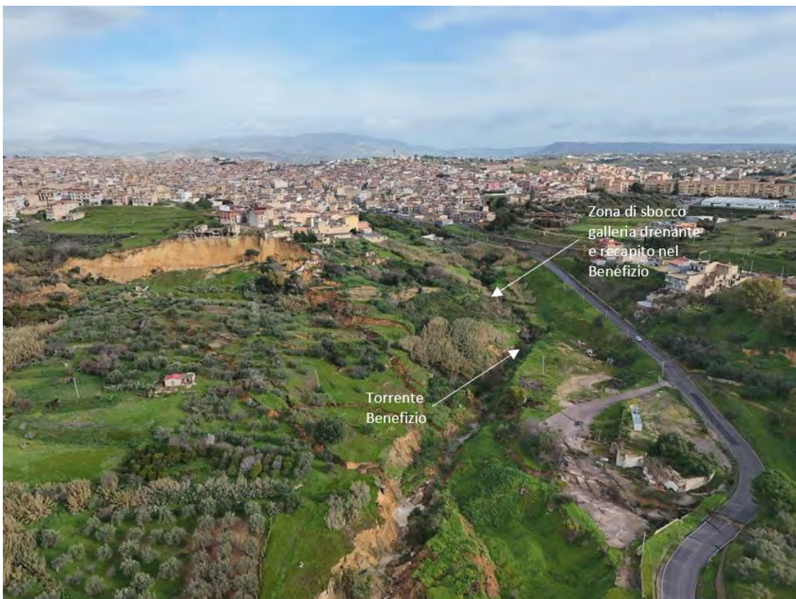
Figura 33 - Zona di sbocco della galleria drenante nel torrente Benefizio.
