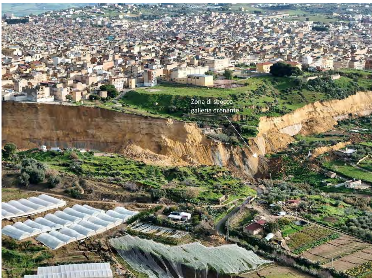
Figura 28 - Zona di sbocco della galleria drenante.
