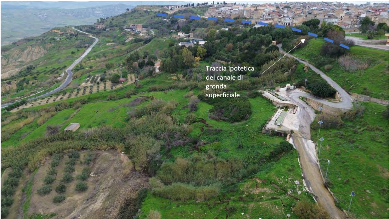
Figura 23 - Vista completa del versante della Frana Nord con evidenza del posizionamento sommitale del canale di gronda per il recapito delle acque di scolo superficiale nei recettori posti a nord.
