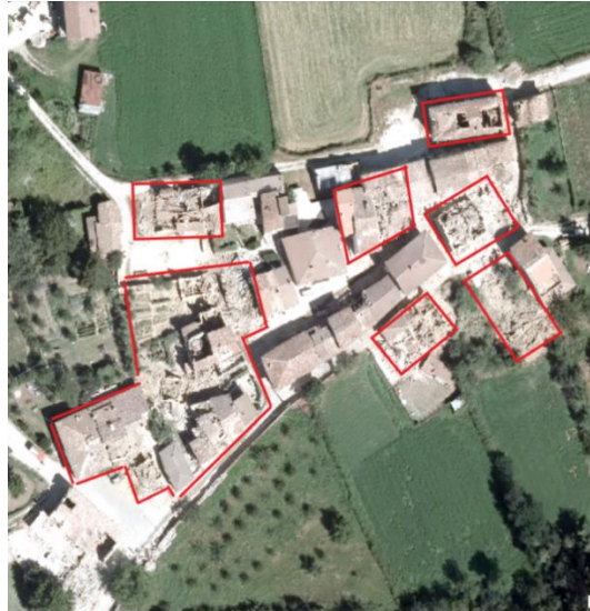
Figura 4 – Esempio di delimitazione perimetrale dell’area danneggiata (foto DPC)
