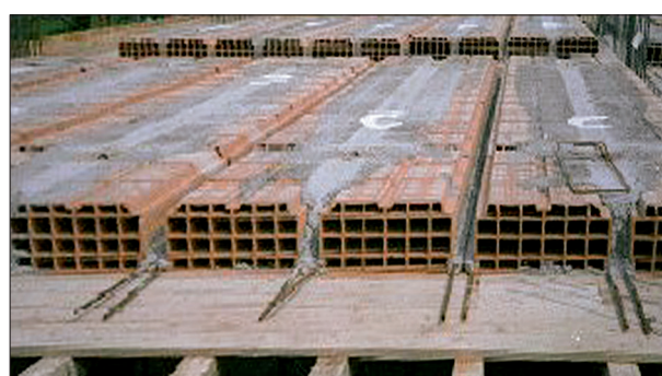
Solaio in laterocemento gettato in opera.
