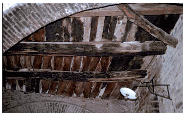
Solaio in legno con tavolata a semplice orditura.
