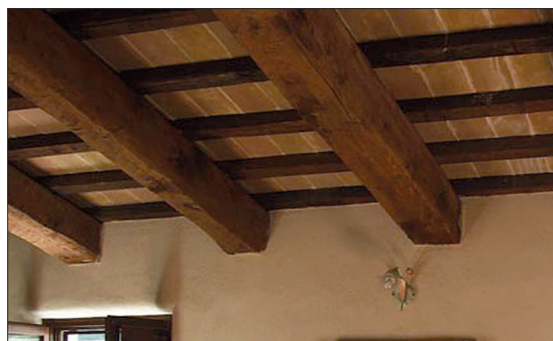
Solaio in legno con mezzana
