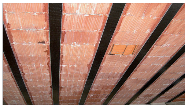
Solaio in ferro e tavelloni.
