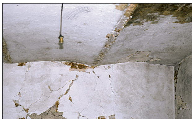
Solaio con travi di ferro a voltine.
