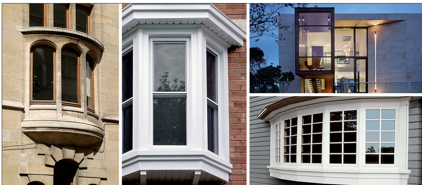
Figura 8. Esempi di bow windows.
